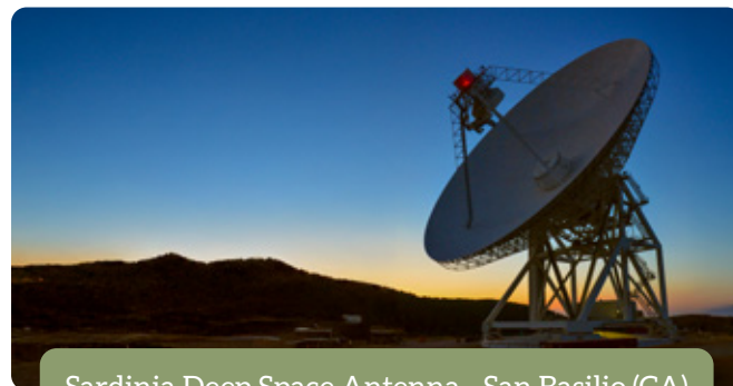
Sardinia Deep Space Antenna - San Basilio (CA)
