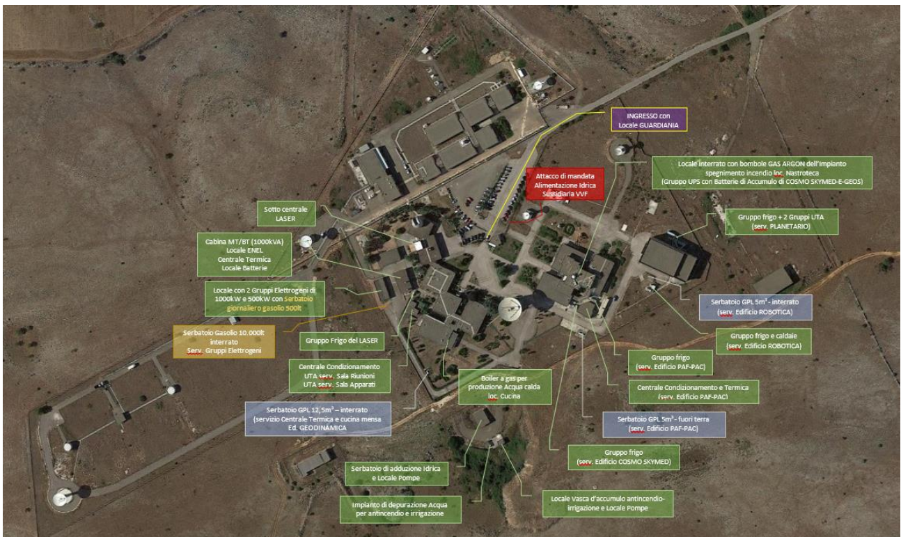
Fig. 5 - Locali Tecnici, Macchine e Apparecchiature di servizio del Centro di Geodesia Spaziale di Matera
