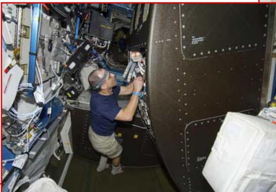
Foto: installazione del Water Recovery System (WRS) sul laboratorio Destiny. Credits: NASA/ESA
