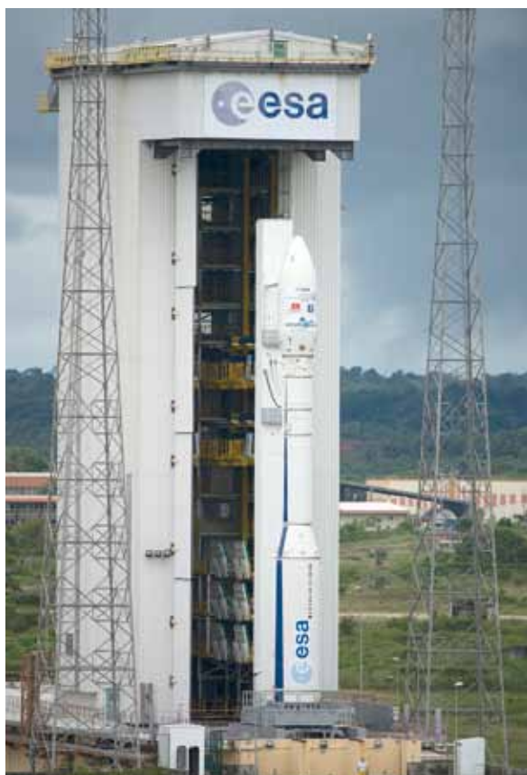
Vega sulla rampa di lancio alla base di Kourou
